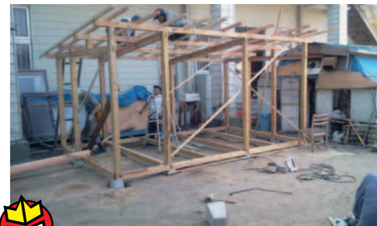
(町民グラウンド仮設の制作過程)
